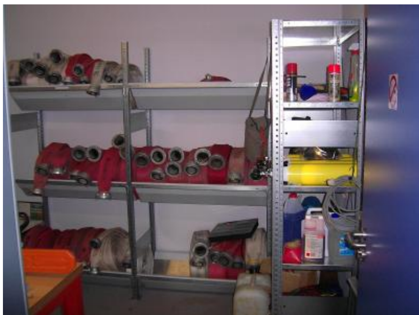
Der Schlauchturm... (Bild 1)
