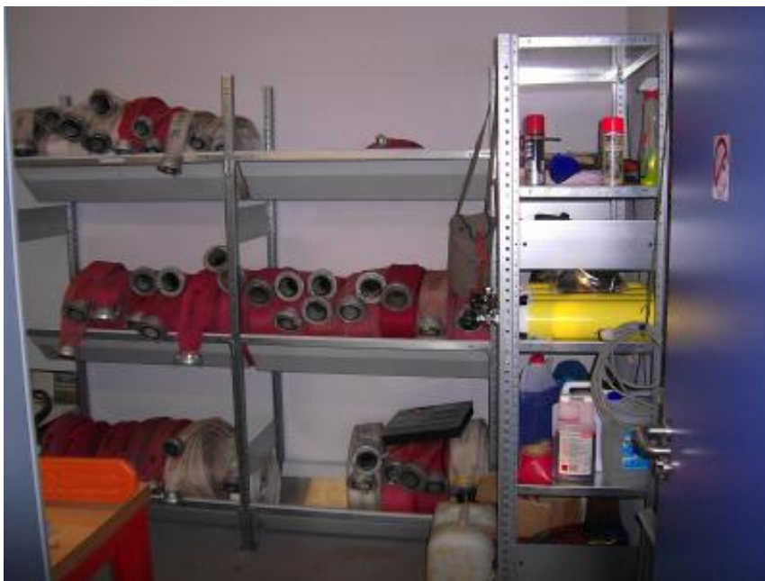
Der Schlauchturm... (Bild 1)
